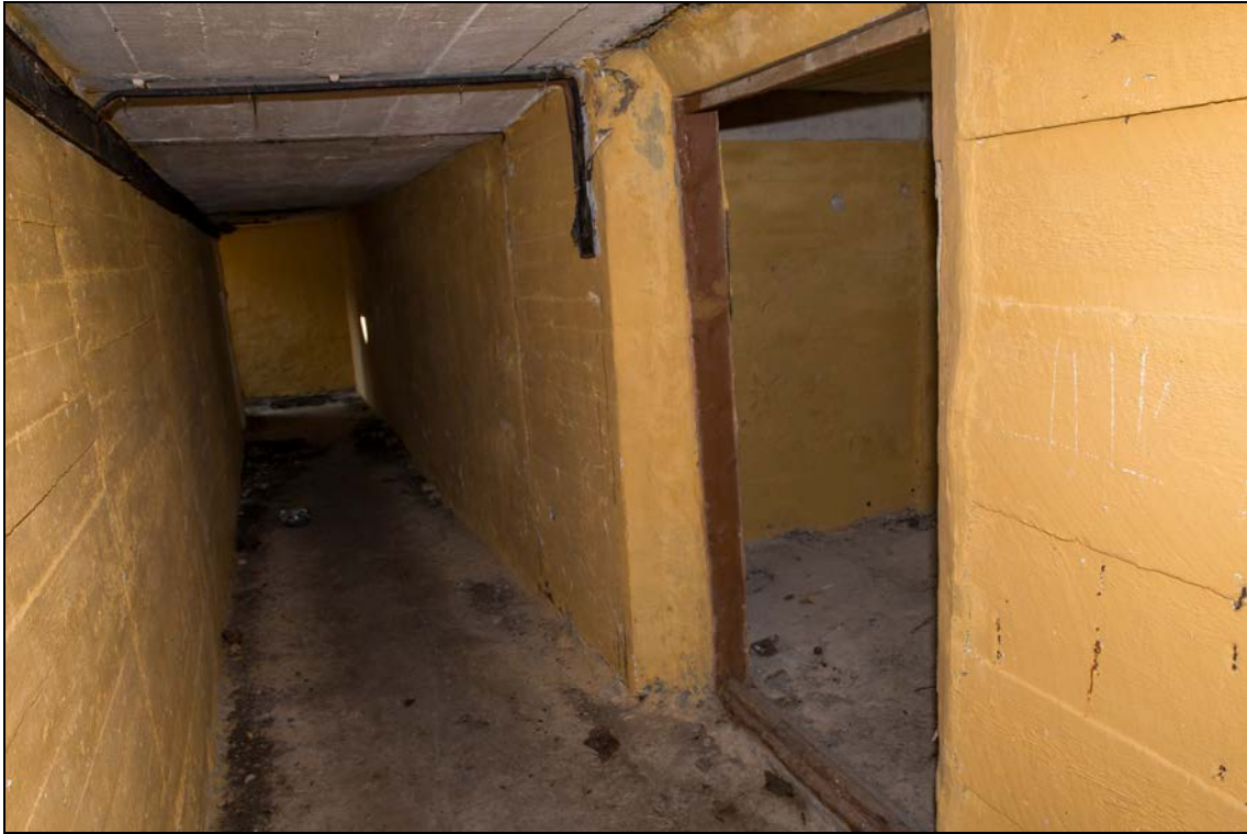
Foto 21 (0412). Ristna patarei. Kahuriõu nr 3 [3] Foto Mart Mõniste 5.03.2014.
