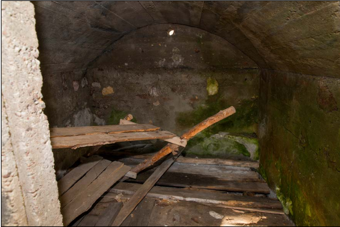
Foto 81 (0048). Ristna patarei. Keldri [19] betoonivalu kvaliteet on nii hea, et sulandub militaarehituste sekka..
