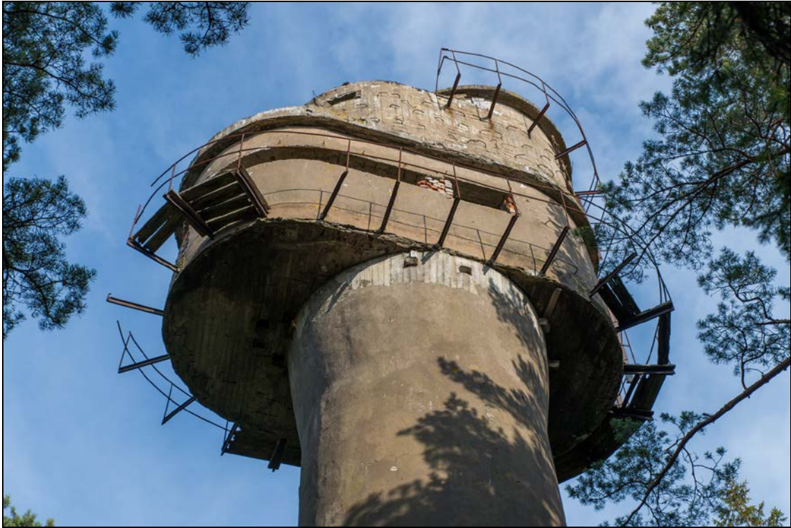
Foto 41 (0958). Ristna patarei. Komandokeskus tulejuhtimistorniga [7] Foto Mart Mõniste 5.03.2014.
