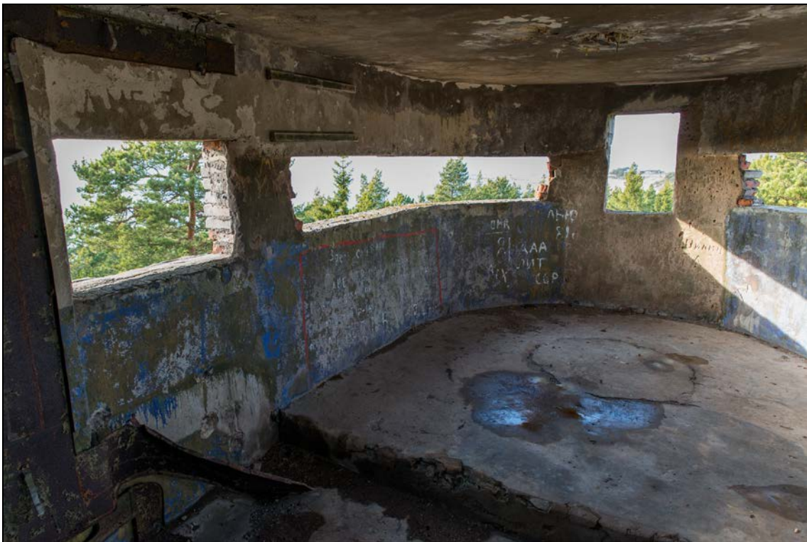
Foto 46 (1072). Ristna patarei. Komandokeskus tulejuhtimistorniga [7]. Foto Mart Mõniste 5.03.2014.
