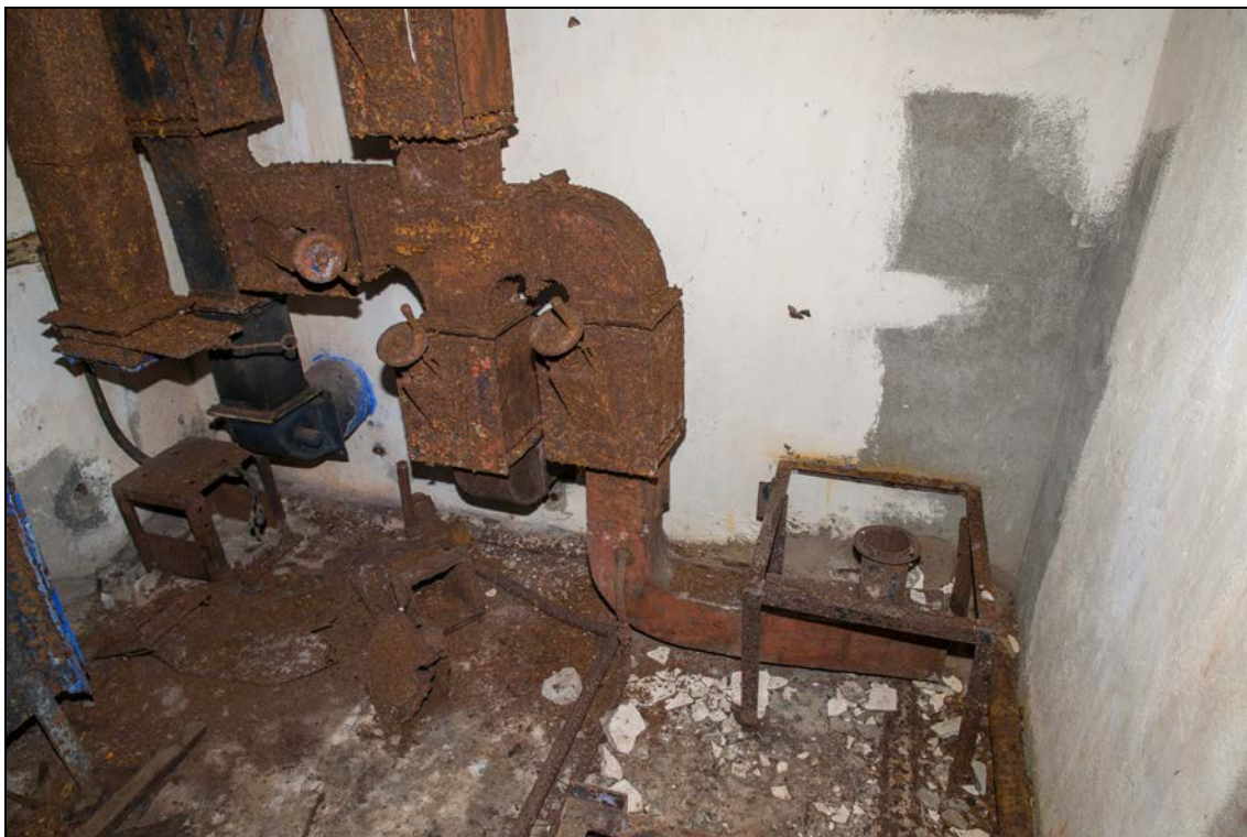
Foto 43 (0998). Ristna patarei. Komandokeskus tulejuhtimistorniga [7]. Ventilatsiooniseadmed. Foto Mart Mõniste 5.03.2014.
