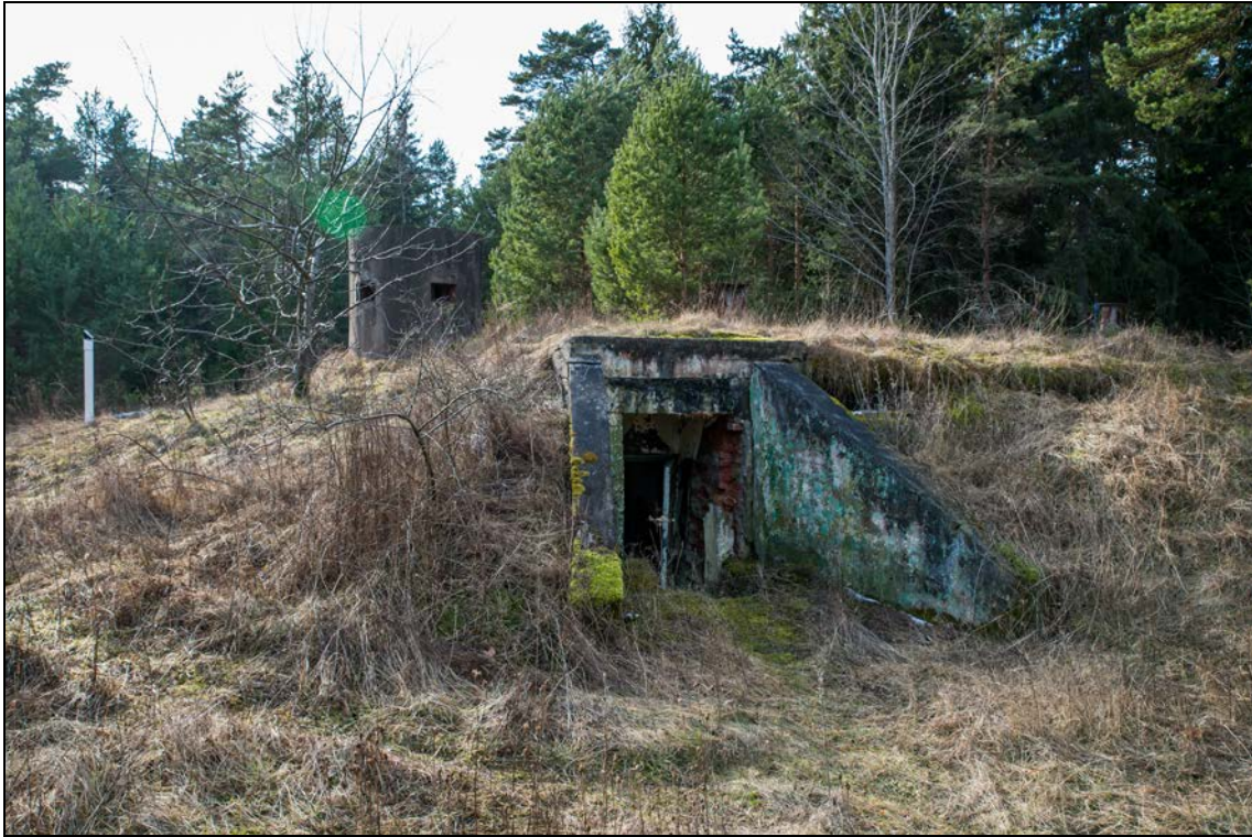
Foto 59 (0783). Ristna patarei. Punker [10], peasissepääs, vaade [20] suunast. Punkris on kokku 20 ruumi.
