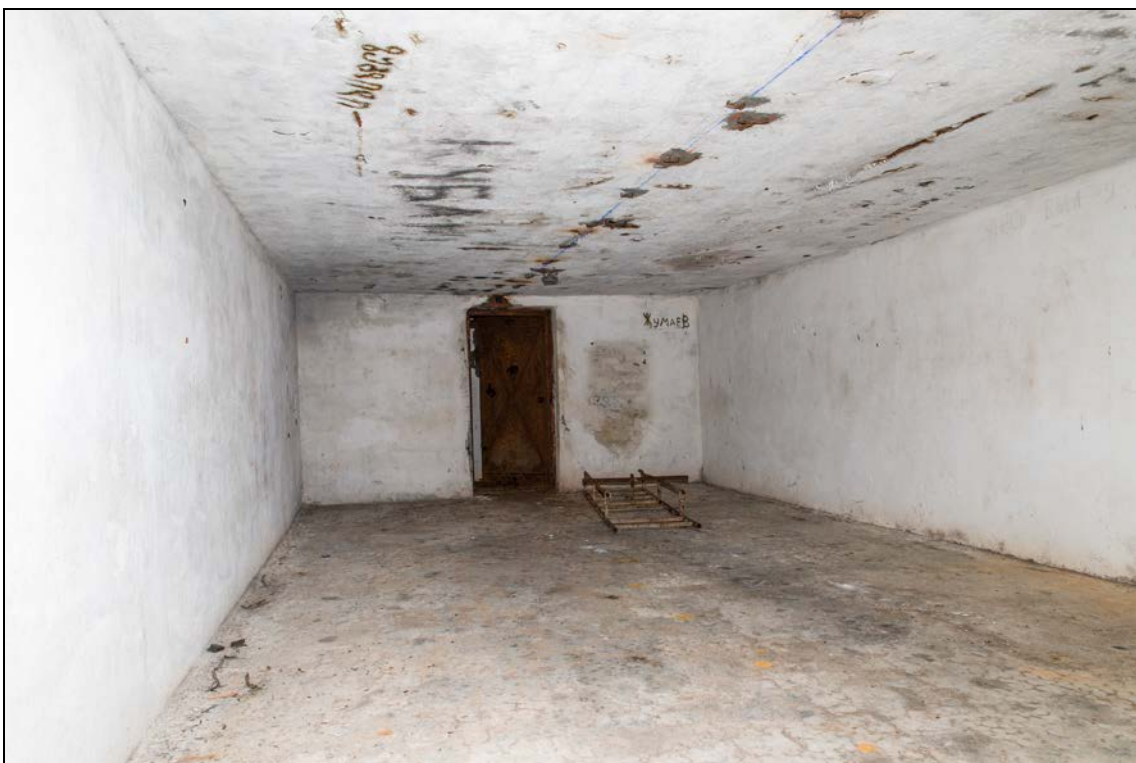
Foto 32 (0909). Ristna patarei. Laskemoonavarjend [5]. Varjendis on kaks suuremat hoidlaruumi. Foto Mart Mõniste 5.03.2014.
