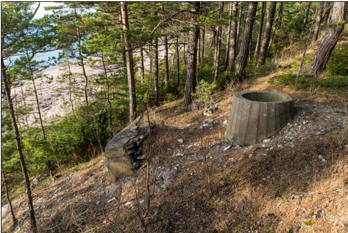
Foto 48 (1089). Ristna patarei. Komandokeskus tulejuhtimistorniga [7]. Foto Mart Mõniste 5.03.2014.
