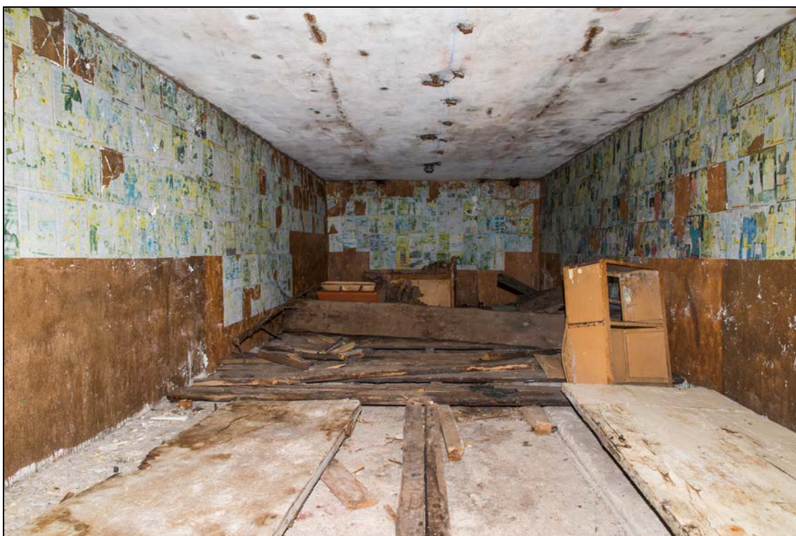
Foto 34 (0925). Ristna patarei. Laskemoonavarjend [5]. Foto Mart Mõniste 5.03.2014.
