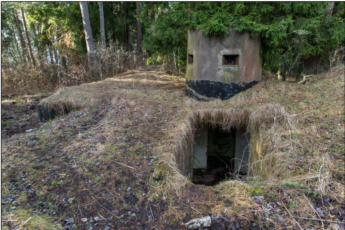
Foto 42 (0965). Ristna patarei. Komandokeskus tulejuhtimistorniga [7]. Komandokeskuse katusel on samuti kaks torni ja sissepääsusi kokku neli. Foto Mart Mõniste 5.03.2014.
