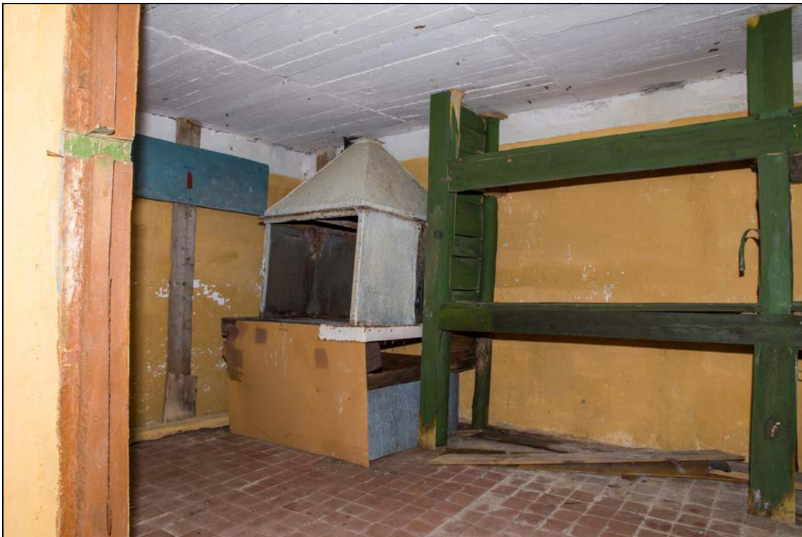
Foto 22 (0421). Ristna patarei. Kahuriõu nr 3 [3] - ühes hoidlas on kummaline tõmbekapi moodi konstruktsioon. Tuld selles tehtud ei ole, tahmajäljed puuduvad. Hoidla suurus 2,5x5,2 m, kõrgus 1,9 m. Foto Mart Mõniste 5.03.2014.
