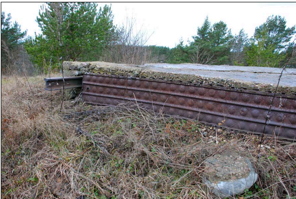
Foto 108 (005). Ristna patarei. Väikese radarimäe [18] platvormi servas olnud metallplaat on läänud vanarauaks. Foto Mart Mõniste 31.01.2008
