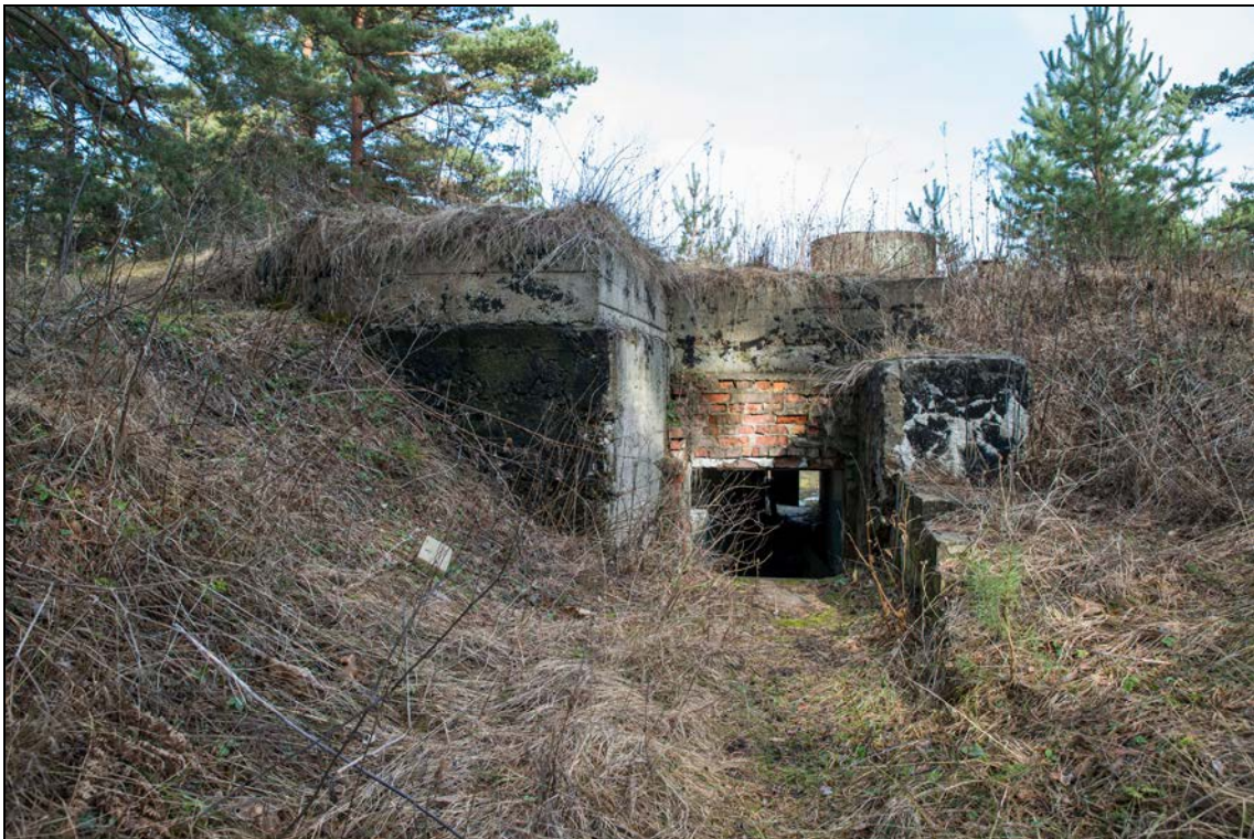
Foto 54 (0769). Ristna patarei. Elektriijaam/komandokeskus [9], tagumine sissepääs. Foto Mart Mõniste 5.03.2014.
