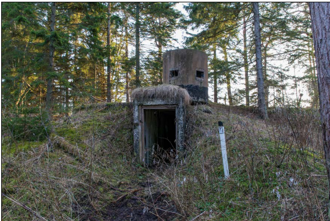
Foto 35 (1284). Ristna patarei. Laskemoonavarjend [6]. Foto Mart Mõniste 5.03.2014.
