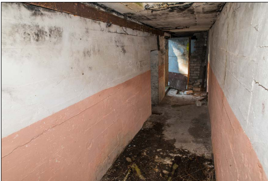
Foto 6 (0095). Ristna patarei. Kahuriõu nr 1 [1] Foto Mart Mõniste 5.03.2014.
