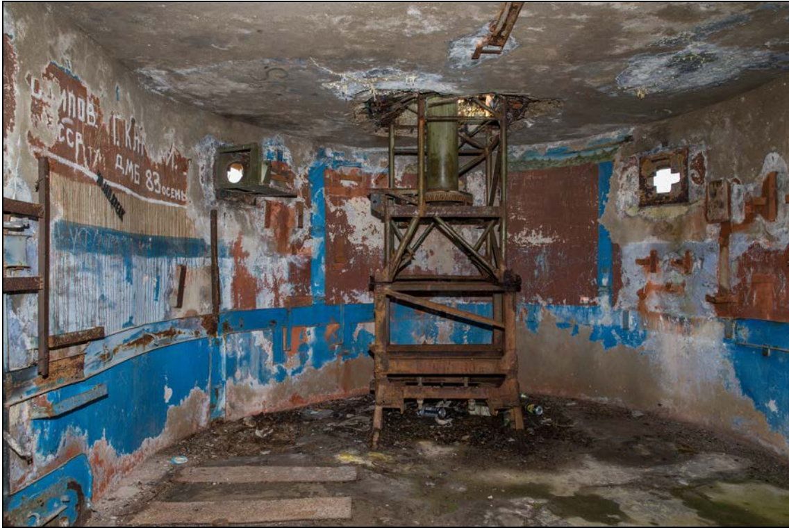
Foto 47 (1080). Ristna patarei. Komandokeskus tulejuhtimistorniga [7]. Foto Mart Mõniste 5.03.2014.
