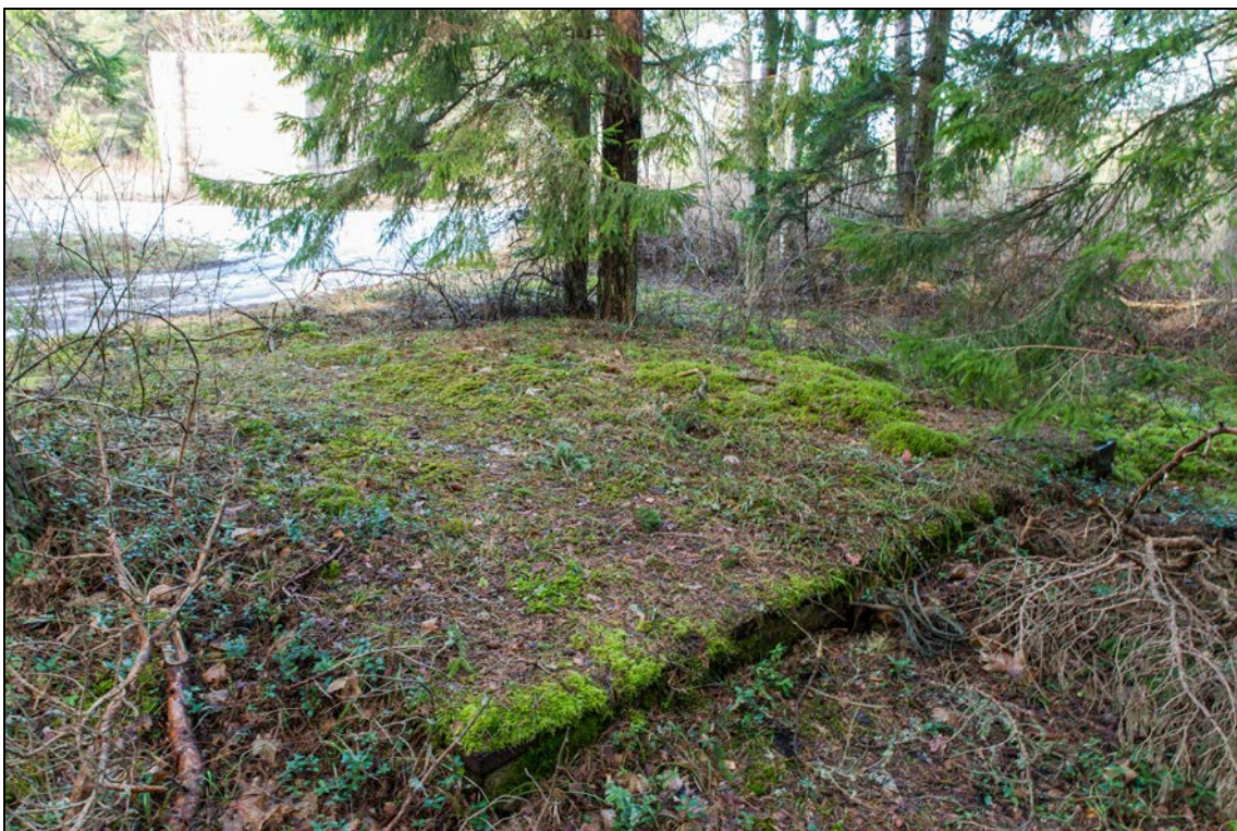
Foto 74 (0689). Ristna patarei. Angaari[16] raudbetoonist värav (4,1x4,2 m, paksus 20 cm) vedeleb angaari taga metsa all, tundub, et see pole paigas olnudki. Foto Mart Mõniste 5.03.2014.
