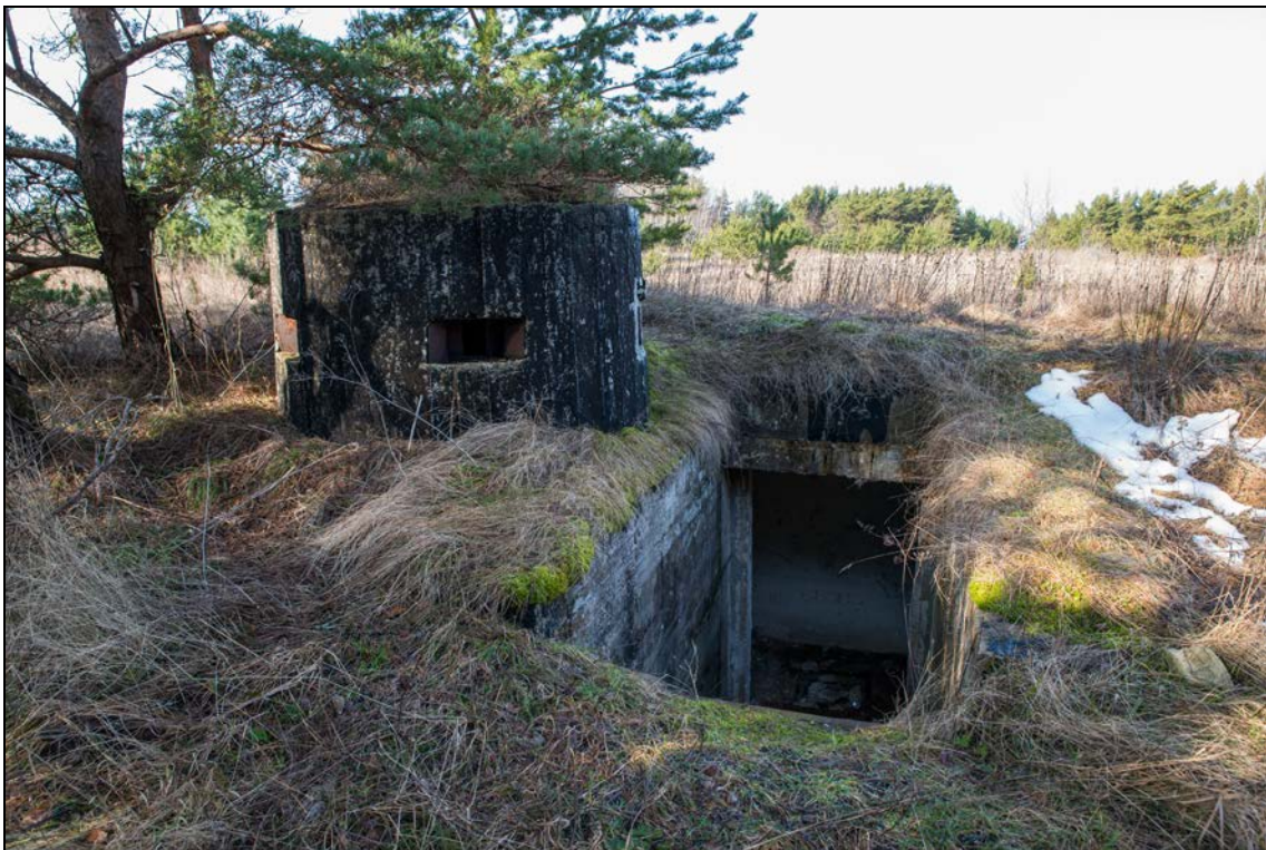
Foto 20 (0441). Ristna patarei. Kahuriõu nr 3 [3] - vasakpoolsel sissepääsul on torn trepist vasakul. Foto Mart Mõniste 5.03.2014.
