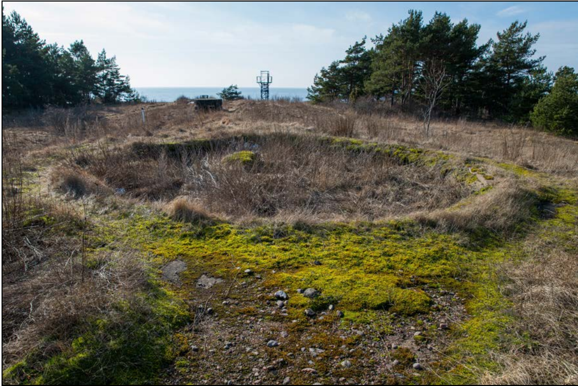
Foto 23 (0570). Ristna patarei. Kahuriõue nr 4 [4] on pinnast täis aetud, õue kõrval olev galerii on osaliselt pinnast täis varisenud. Taga paistab metalltorn [25]. Foto Mart Mõniste 5.03.2014.
