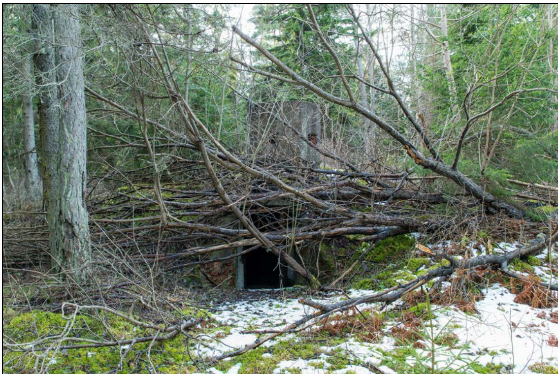
Foto 29 (0872). Ristna patarei. Laskemoonavarjend [5]. Foto Mart Mõniste 5.03.2014.
