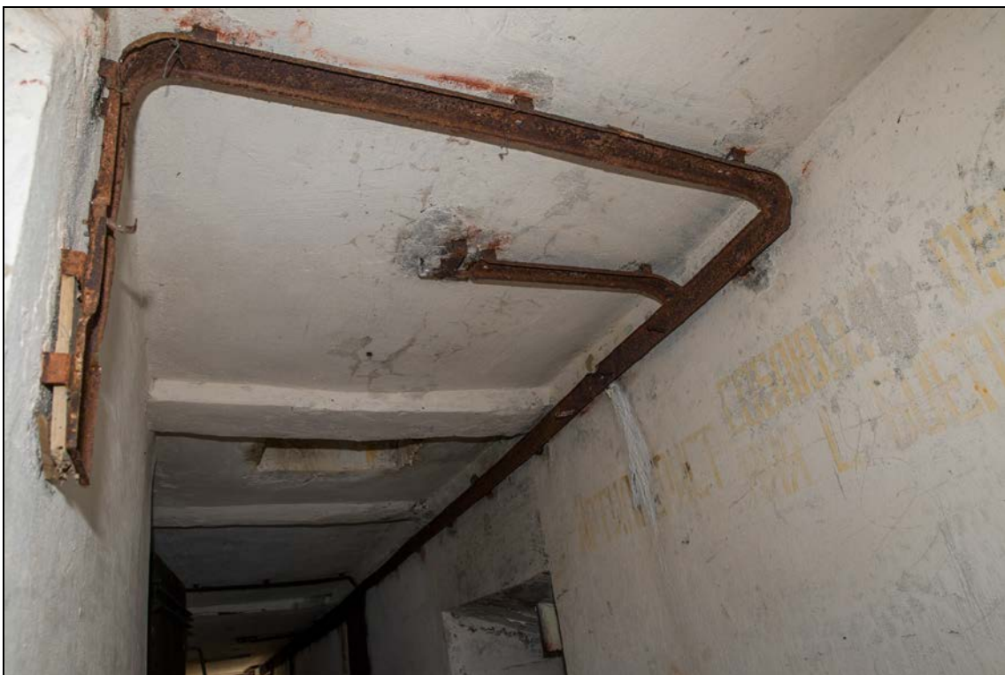
Foto 16 (0366). Ristna patarei. Kahuriõu nr 2 [2], koridoris on säilinud algset elektrikaablite alust. Foto Mart Mõniste 5.03.2014.
