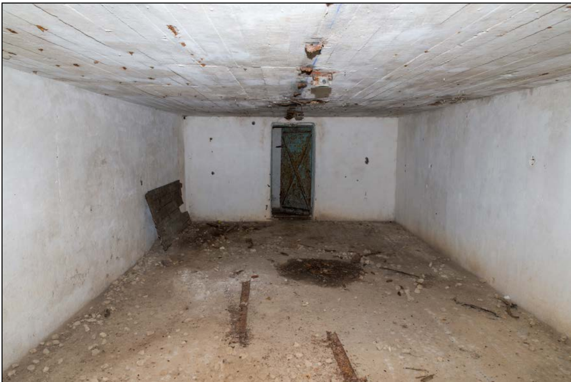
Foto 38 (1299). Ristna patarei. Laskemoonavarjend [6]. Foto Mart Mõniste 5.03.2014.
