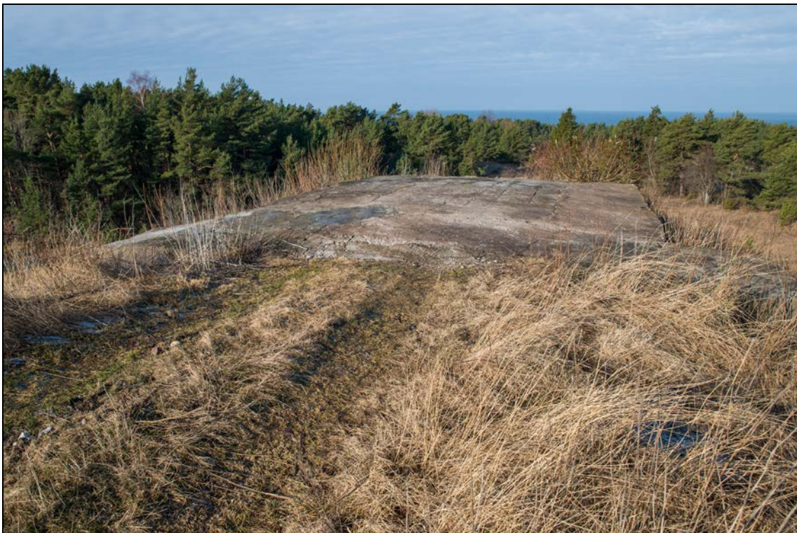
Foto 76 (0016). Ristna patarei. Suure radarimäe [17] otsas on 7x9 m betoonist platvorm, vaade [24] suunast.
