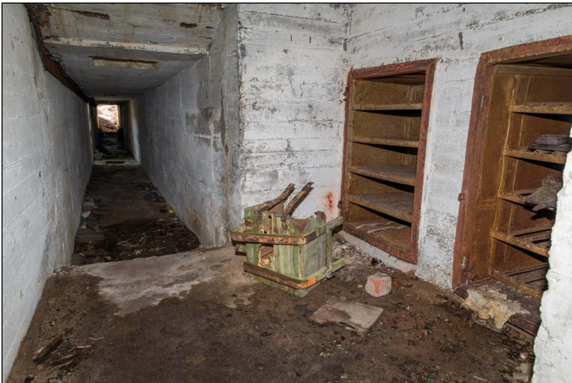
Foto 26 (0595). Ristna patarei. Kahuriõue nr 4 [4], vaade galerii poolt edelapoolsesse tiiba. Foto Mart Mõniste 5.03.2014.
