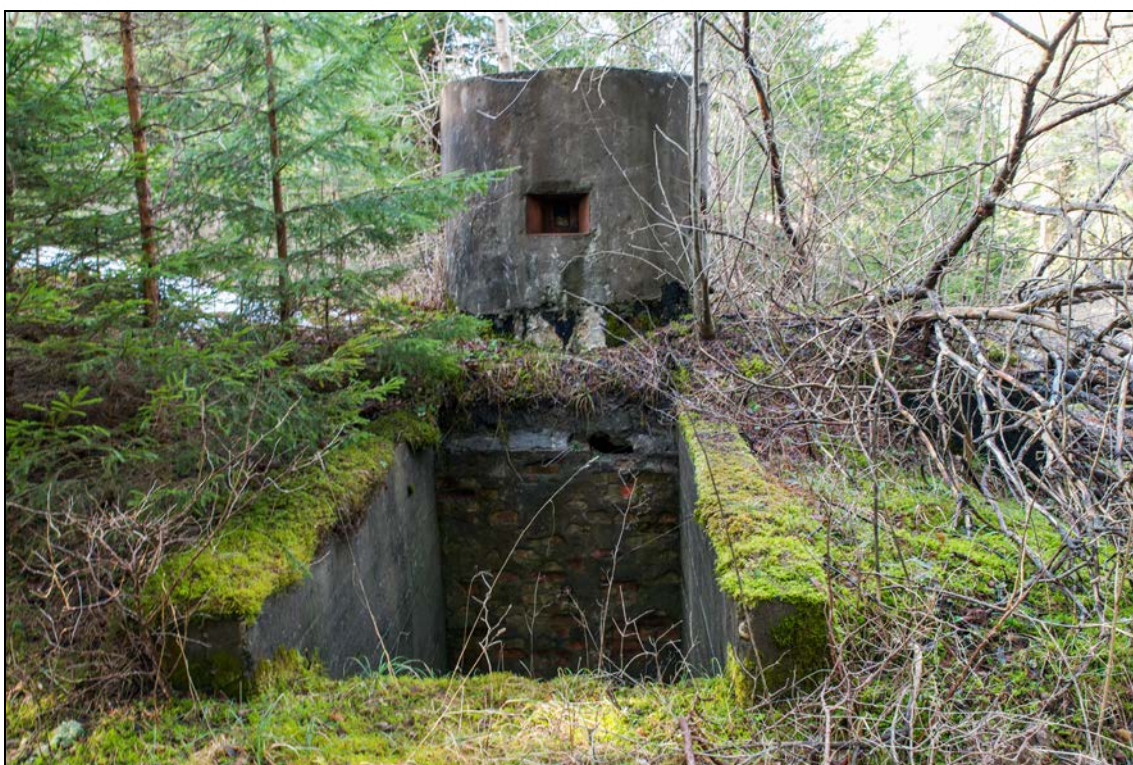
Foto 30 (0874). Ristna patarei. Laskemoonavarjend [5]. Katusel torn, neljast sissepääsust kolm on suletud. Foto Mart Mõniste 5.03.2014.
