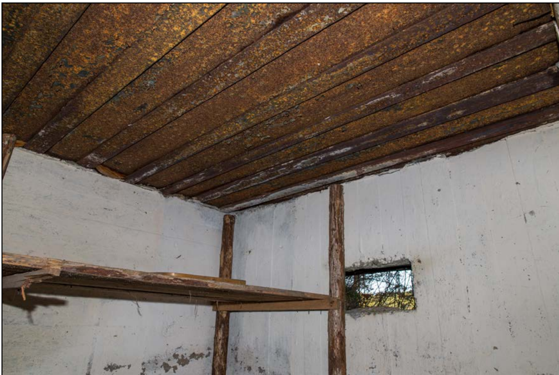
Foto 66 (1222). Ristna patarei. Dott [11] laes on säilinud metallist killukaitse, sisustuseks rohmakas riiul. Foto Mart Mõniste 5.03.2014.
