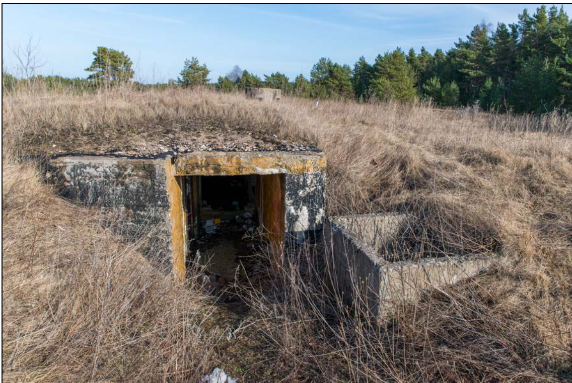
Foto 24 (0657). Ristna patarei. Kahuriõue nr 4 [4] merepoolse otsa sissepääsu kõrval on betoonist kast, mida mujal ei ole. Foto Mart Mõniste 5.03.2014.
