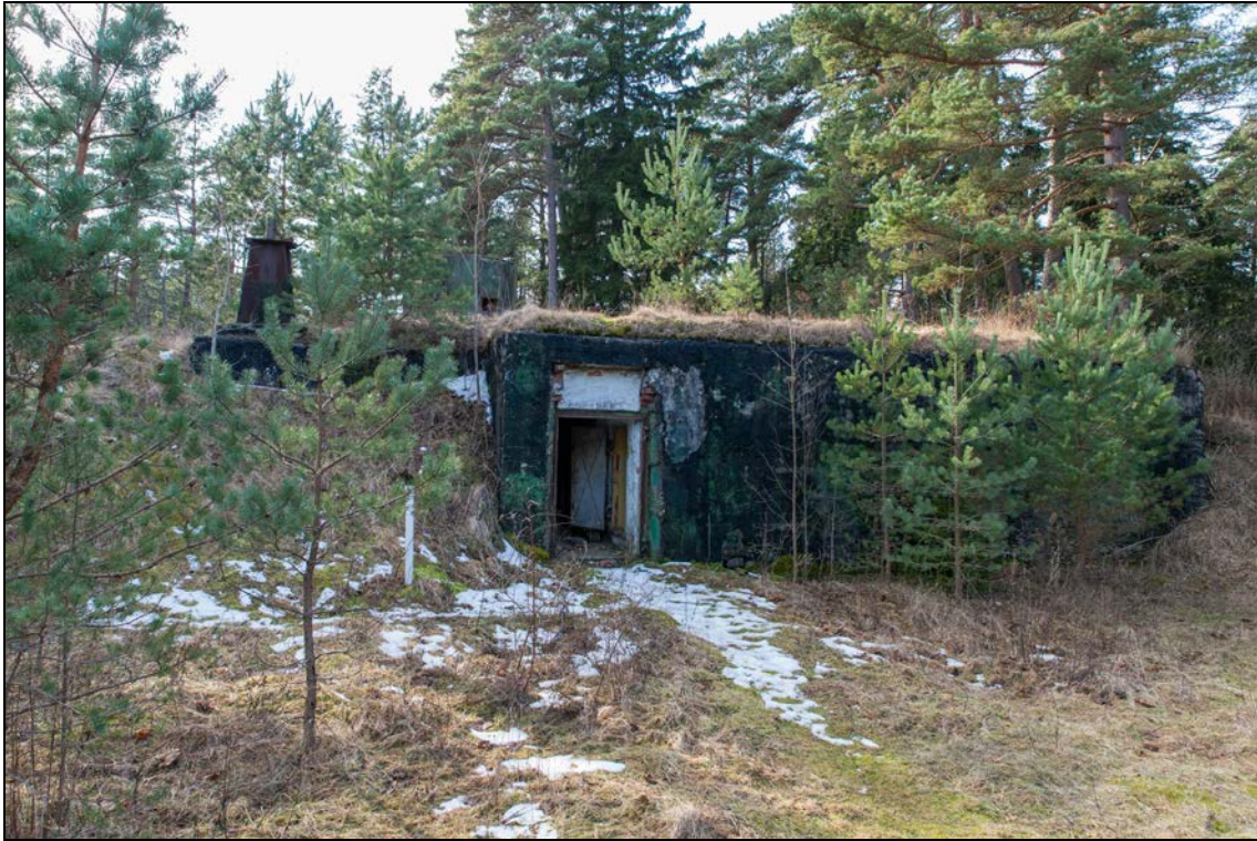
Foto 53 (0693). Ristna patarei. Elektriijaam/komandokeskus [9], vaade riviplatsi [15] suunast. Punkri ehitusalune pind on u 200 m 2 , aga eraldi ruume on 19. Lae paksus 60 cm. Foto Mart Mõniste 5.03.2014.
