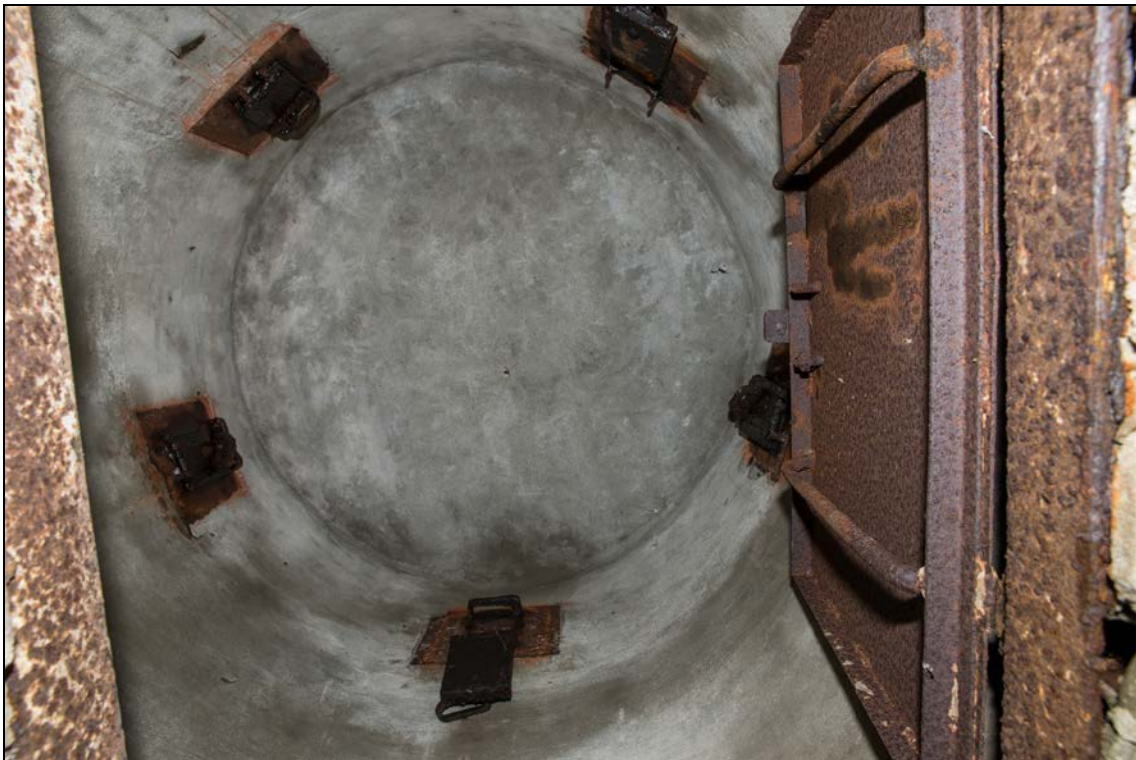
Foto 10 (0186). Ristna patarei. Kahuriõu nr 1 [1]. Torni sisevaade - viis luukidega suletavat ambrasuuri, torni läbimõõt 1,5 m, kõrgus 1,75 m, luuk põrandas 60x80 cm, alumine korrus neljakandiline 1,5x1,5 m, kõrgus 1,4 m.
