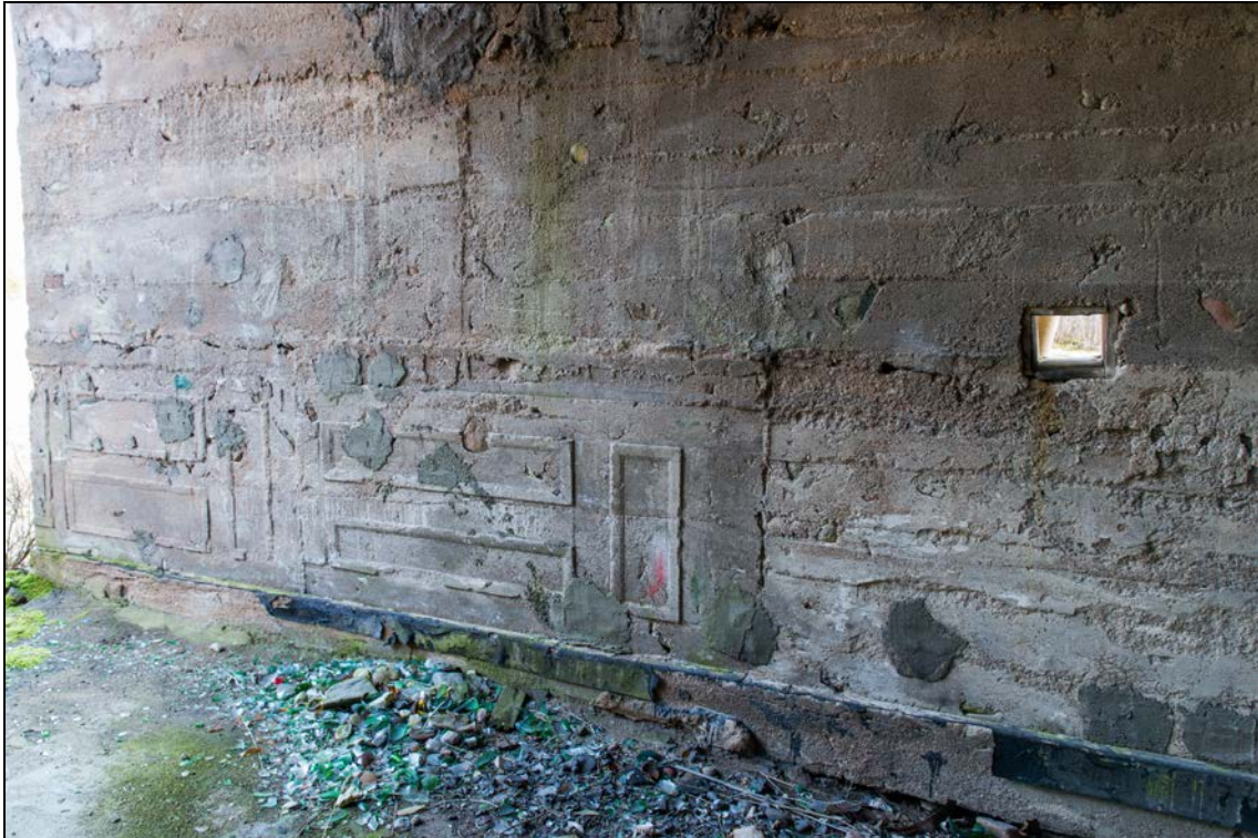
Foto 73 (0674). Ristna patarei. Angaar [16], ehituskvaliteet silmatorkavalt rohmakas. Foto Mart Mõniste 5.03.2014.
