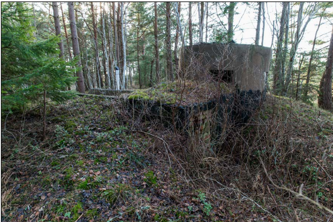
Foto 50 (1204). Ristna patarei. Doti [8] ehitus tundub olevat pooleli jäänud, tagaseinas on kinnimüüritud ukseava ja selle ees süvend. Foto Mart Mõniste 5.03.2014.
