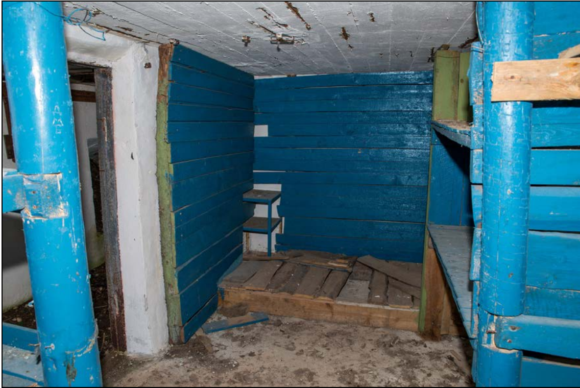
Foto 13 (0235). Ristna patarei. Kahuriõu nr 2 [2] laskemoonahoidlaid on kasutatud radarijaama ajal ladudena.
