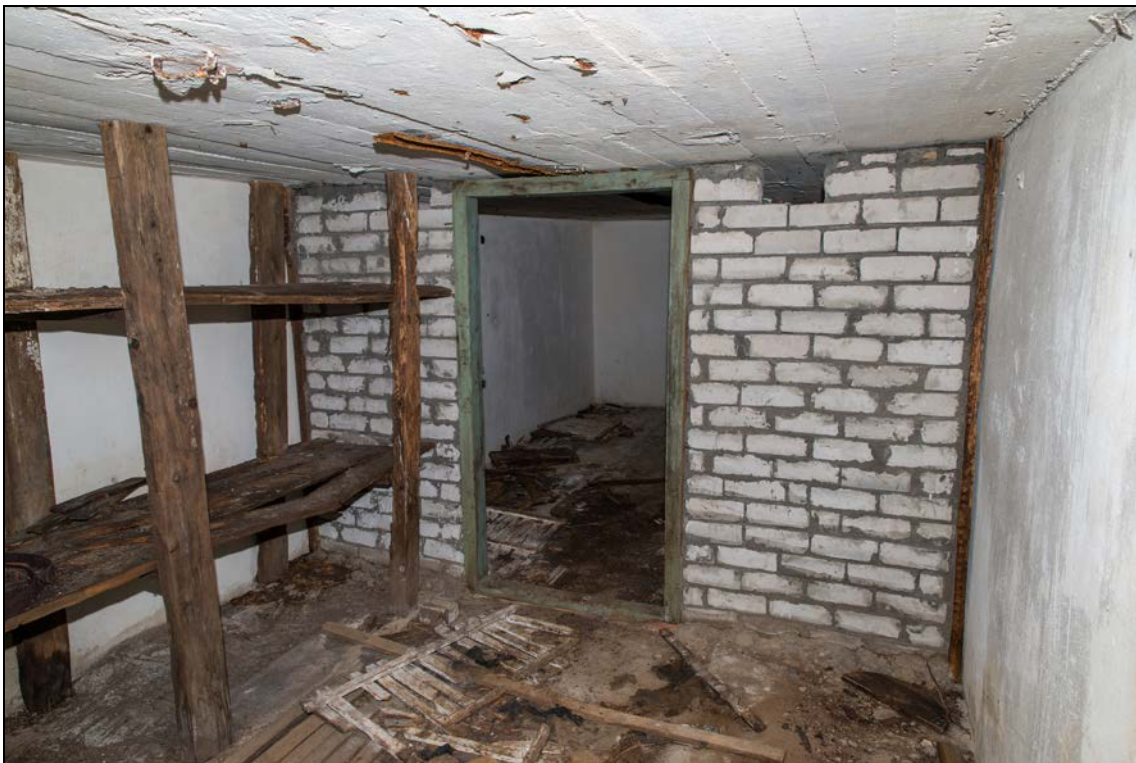
Foto 40 (1320). Ristna patarei. Laskemoonavarjend [6]. Foto Mart Mõniste 5.03.2014.
