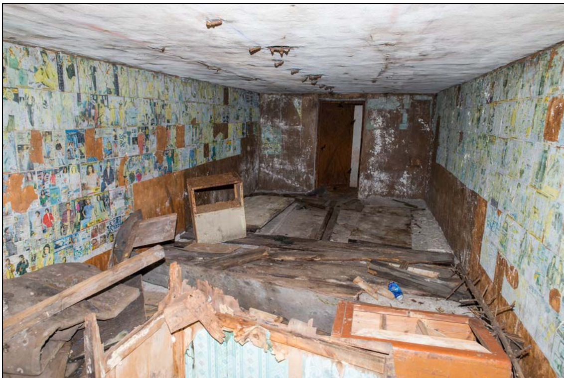
Foto 33 (0928). Ristna patarei. Laskemoonavarjend [5]. Foto Mart Mõniste 5.03.2014.
