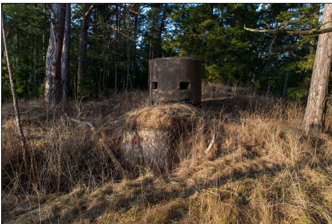
Foto 36 (1270). Ristna patarei. Laskemoonavarjend [6]. Foto Mart Mõniste 5.03.2014.
