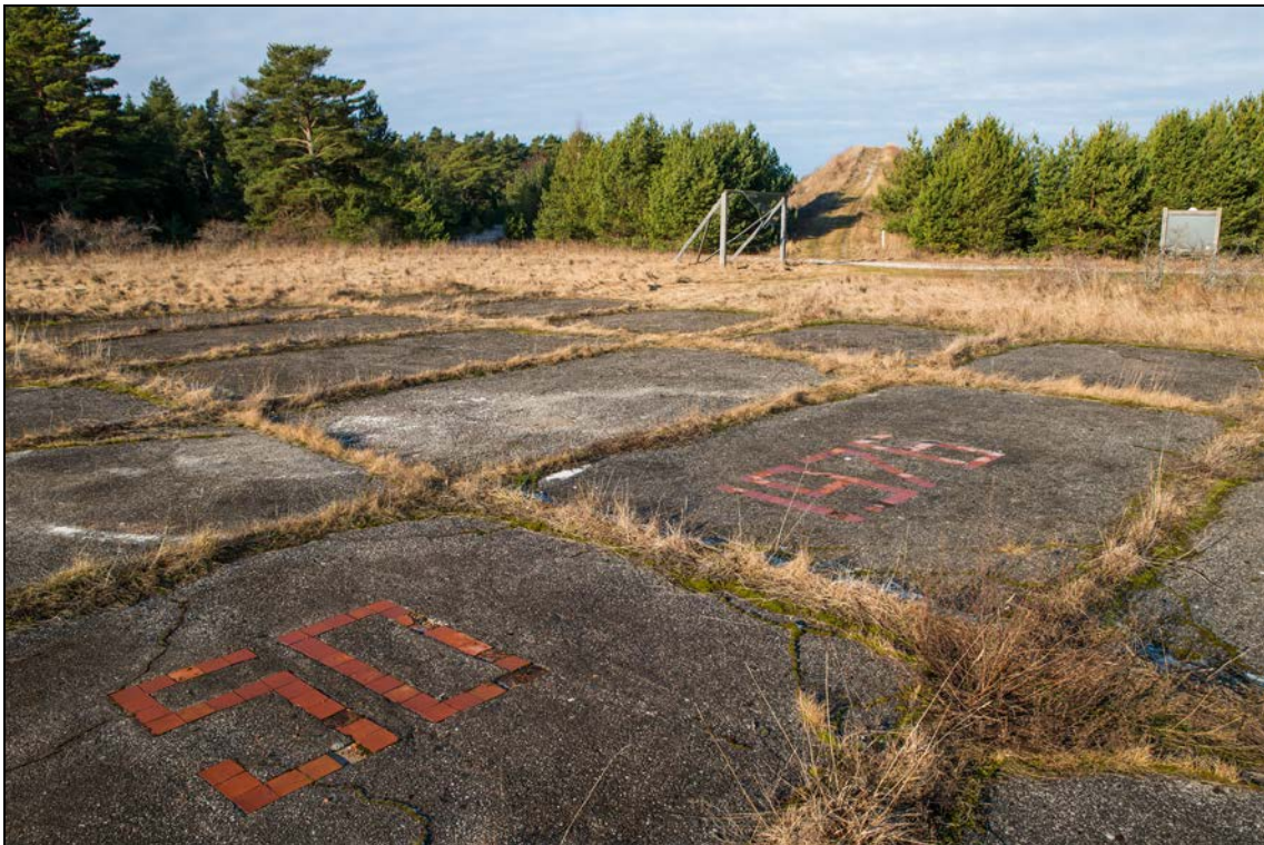
Foto 93 (0007). Ristna patarei. Kopteriplats [24], taga paistab suur radarimägi [17]. Plats koosneb betoonplaatidest 3x5 ja 3x4 m, kogusuurus 20x24 m. Foto Mart Mõniste 5.03.2014.
