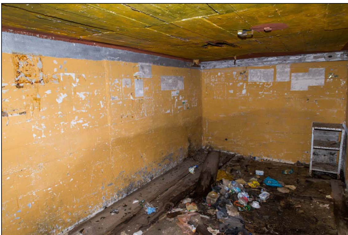
Foto 28 (0642). Ristna patarei. Kahuriõu nr 4 [4] Foto Mart Mõniste 5.03.2014.
