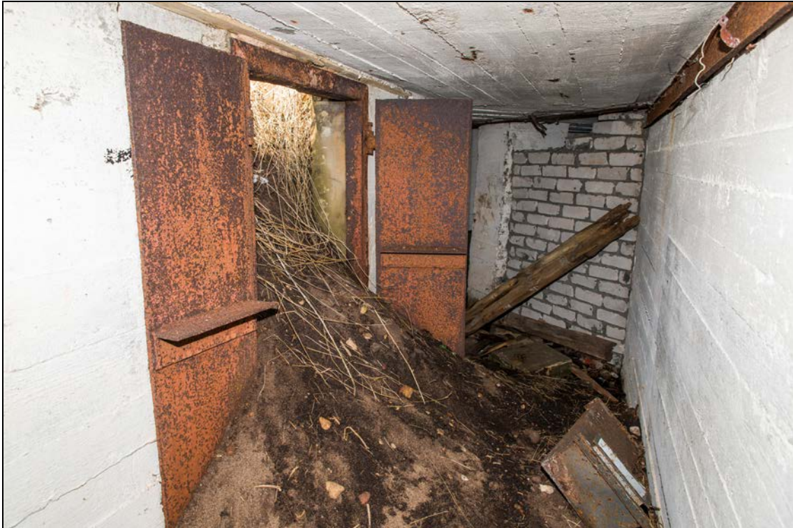
Foto 25 (0615). Ristna patarei. Kahuriõue nr 4 [4] galeriis on ainsana säilinud metallist luugid. Taga paistab kinnimüüritud sissepääs kirdepoolsesse tiiba. Foto Mart Mõniste 5.03.2014.
