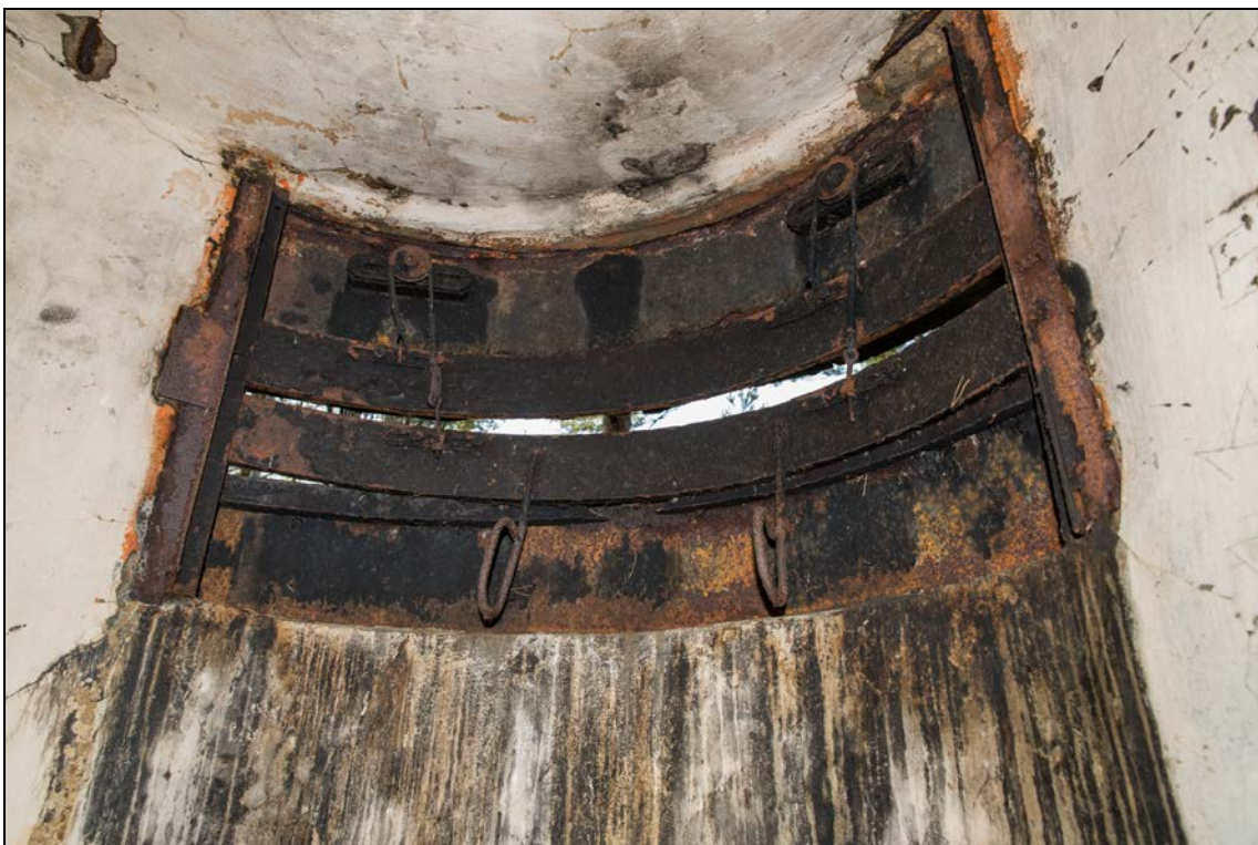
Foto 52 (1200). Ristna patarei. Dott [8] laia ambrasuuri sulgemismehhanism on säilinud. Foto Mart Mõniste 5.03.2014.
