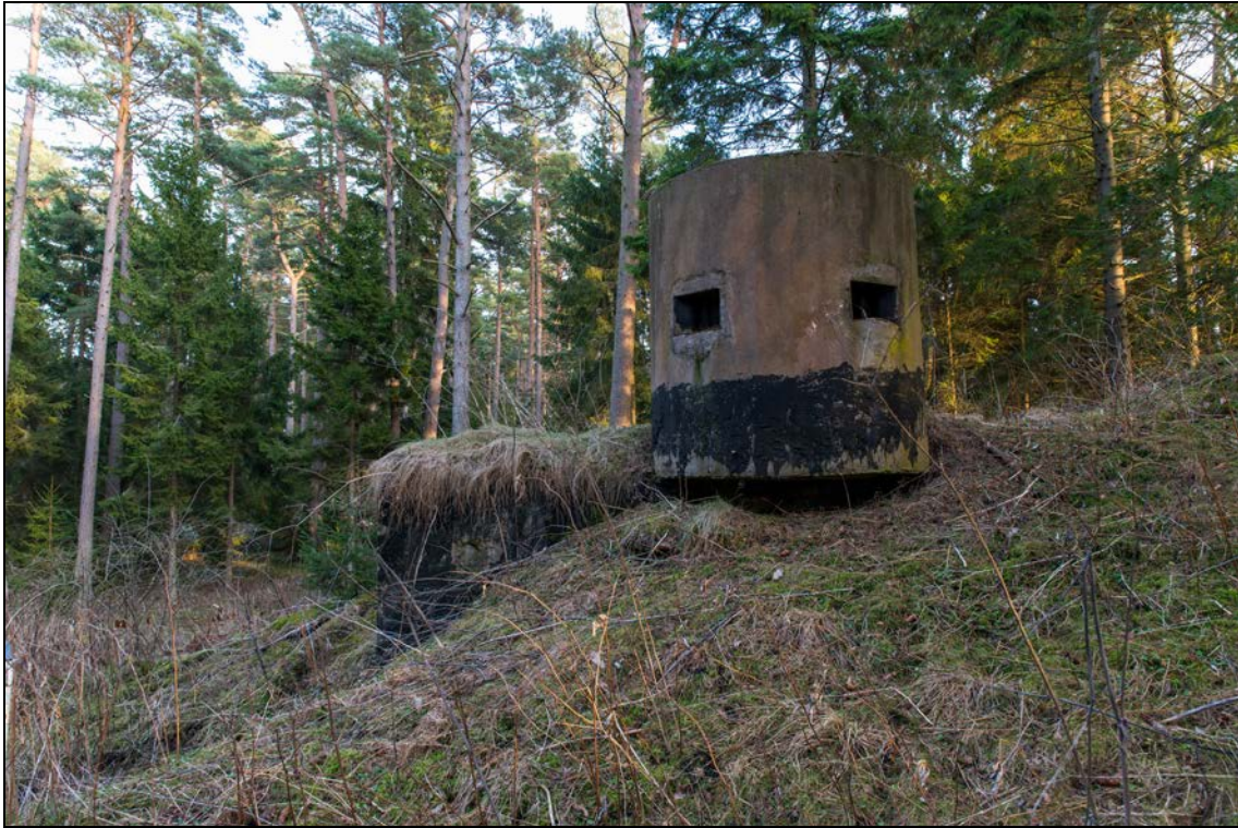
Foto 37 (1338). Ristna patarei. Laskemoonavarjend [6]. Foto Mart Mõniste 5.03.2014.
