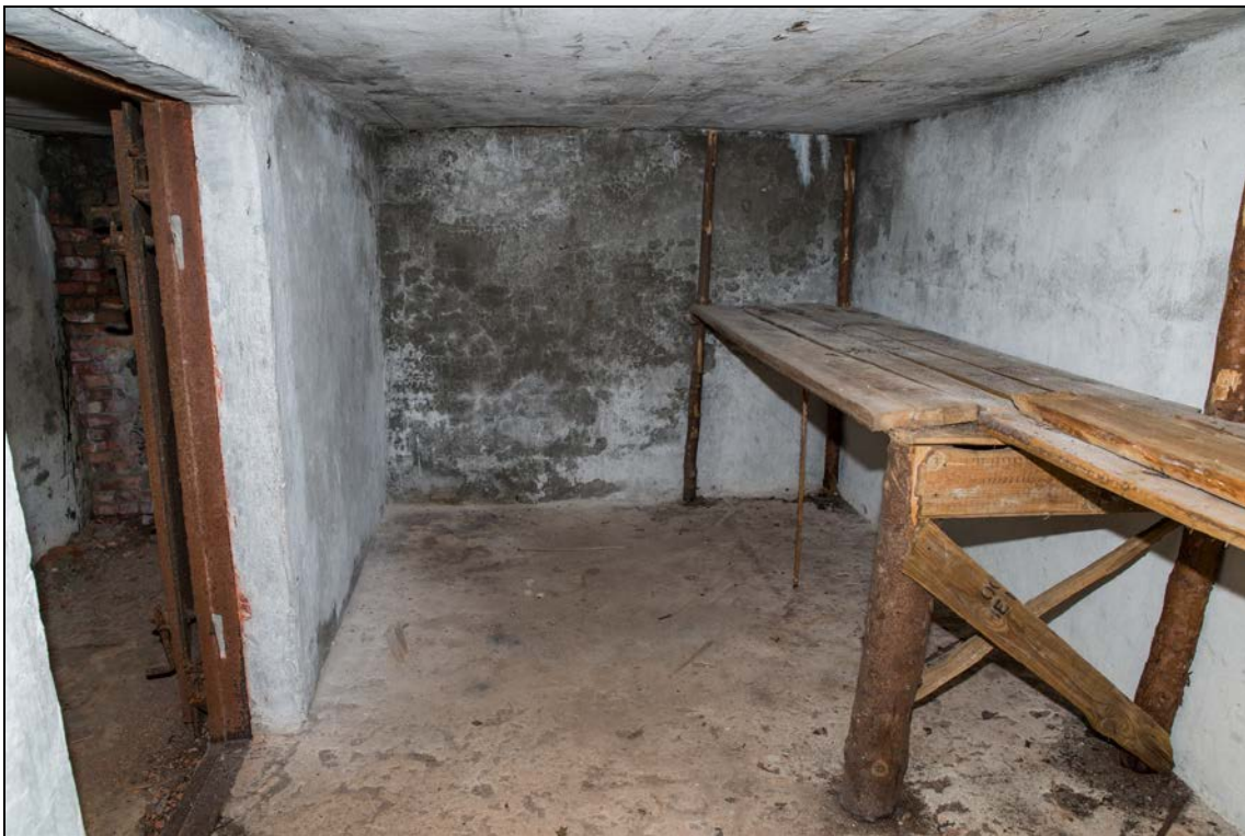
Foto 14 (0354). Ristna patarei. Kahuriõu nr 2 [2]
