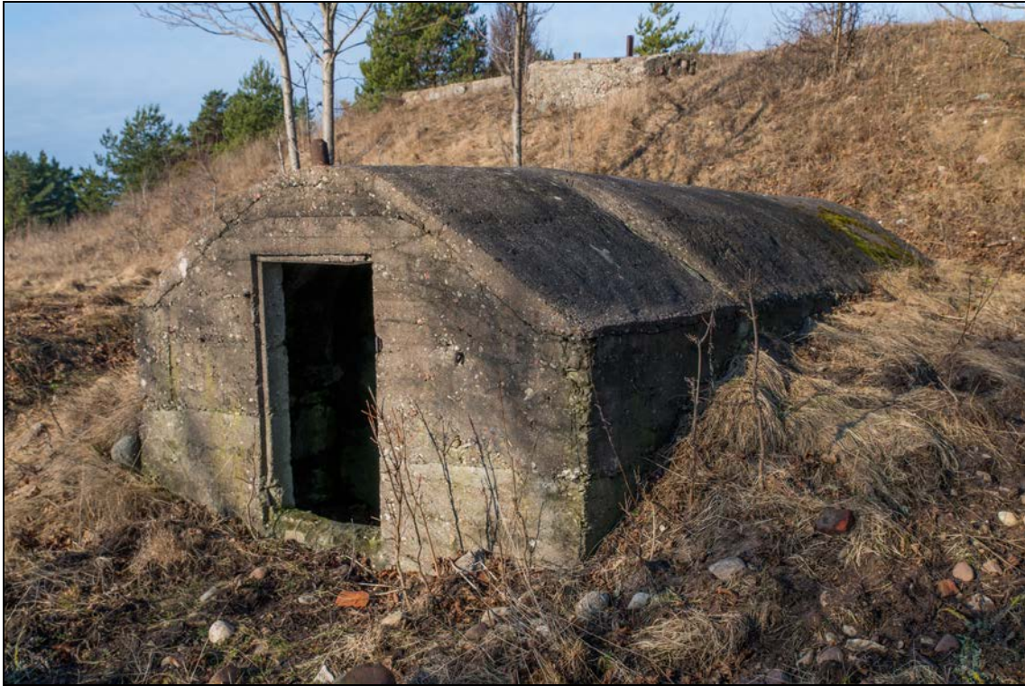
Foto 79 (0038). Ristna patarei. Kelder [19] on säilinud patarei kohal olnud talust. Foto Mart Mõniste 5.03.2014.
