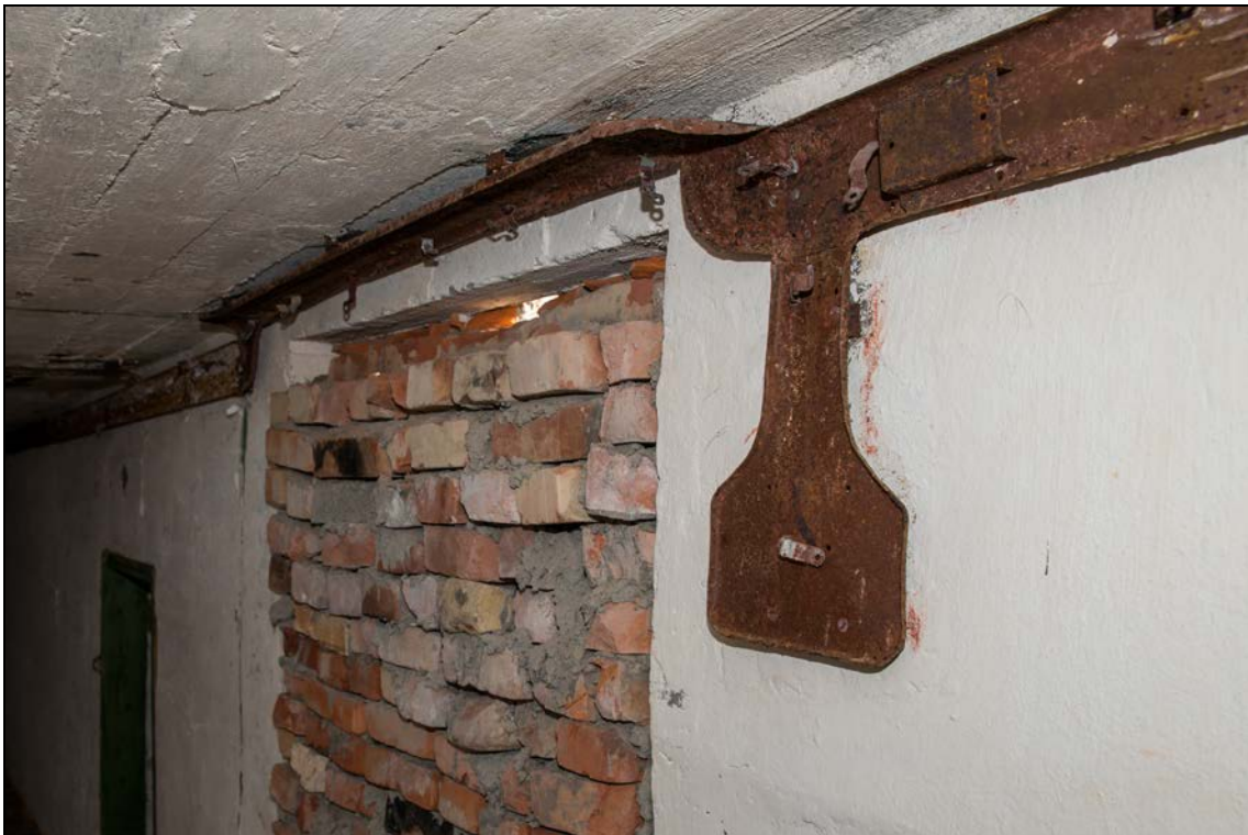
Foto 15 (0269). Ristna patarei. Kahuriõu nr 2 [2] Foto Mart Mõniste 5.03.2014.
