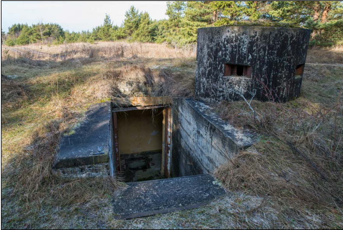
Foto 19 (0386). Ristna patarei. Kahuriõu nr 3 [3] - tagumised sissepääsud torniga on sümmetrilised - parempoolsel on torn trepist paremal, ... Foto Mart Mõniste 5.03.2014.
