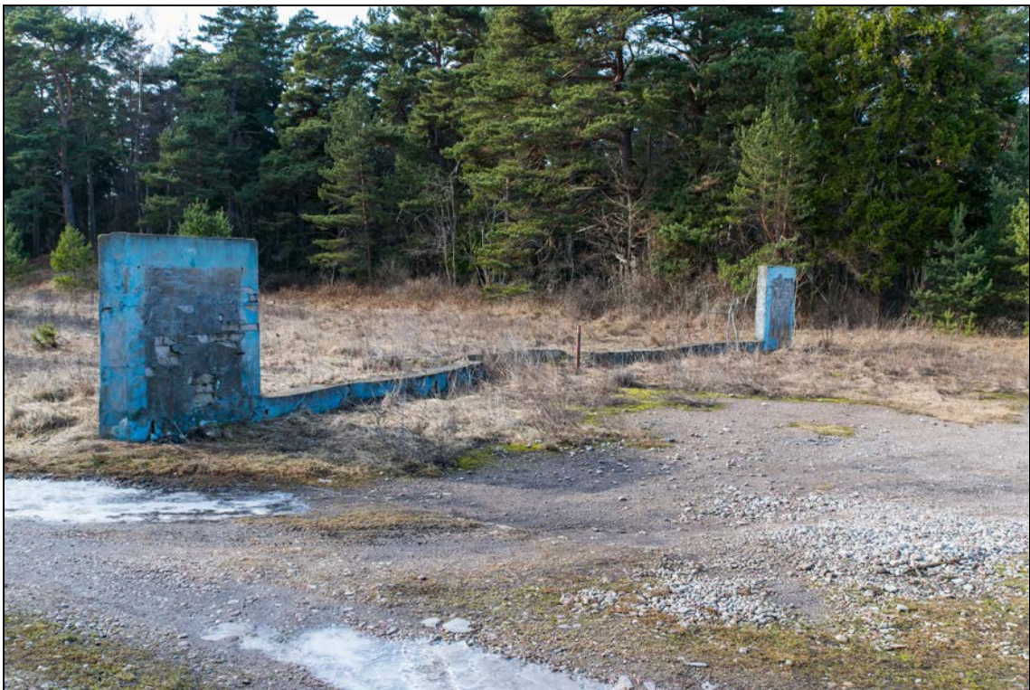
Foto 70 (0664). Ristna patarei. Riviplats [15] paraadseinaga, vaade [24] suunast. Foto Mart Mõniste 5.03.2014.
